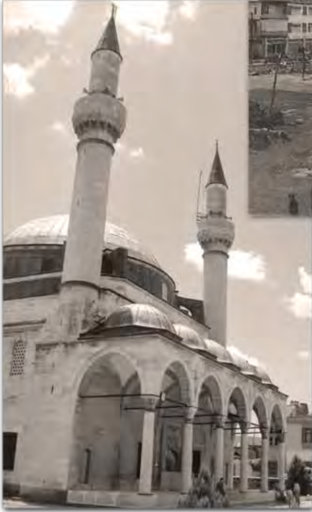
Sultan Selim Camii Ve Külliyesi Restorasyon Öncesi Ve Sonrası
