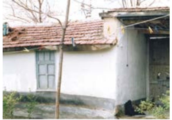
Fotoğraf 3: Evin çatı örtüsü
